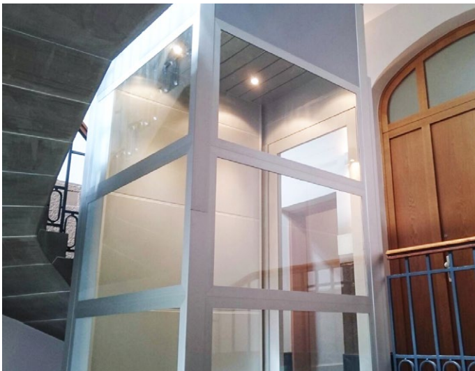
Im Treppenauge verbaut
